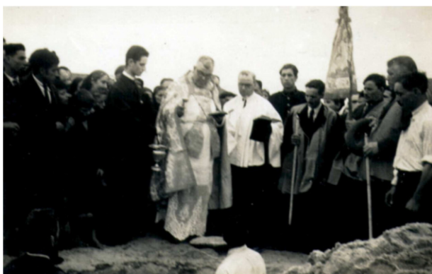
13. Lançamento da 1ª pedra da Capela da Praia , 1941 (AMO)
