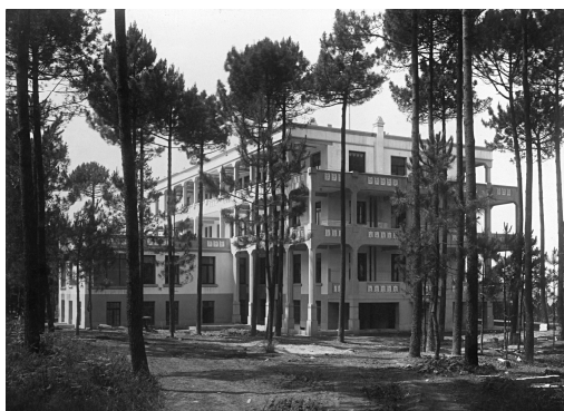
Vista geral da Clínica Heliantia (Fonte: AHCMP F-P-04-FA-ALB-0002).
